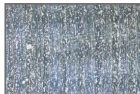
Stan wykończenia powierzchni
